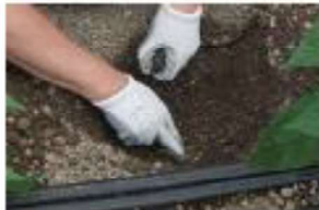
①Sensorを設置するための 穴を掘ります
