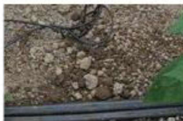
⑤ある程度、細かい土を載せた後は、 周囲の土も混ぜて、更に載せて埋め込みます。
